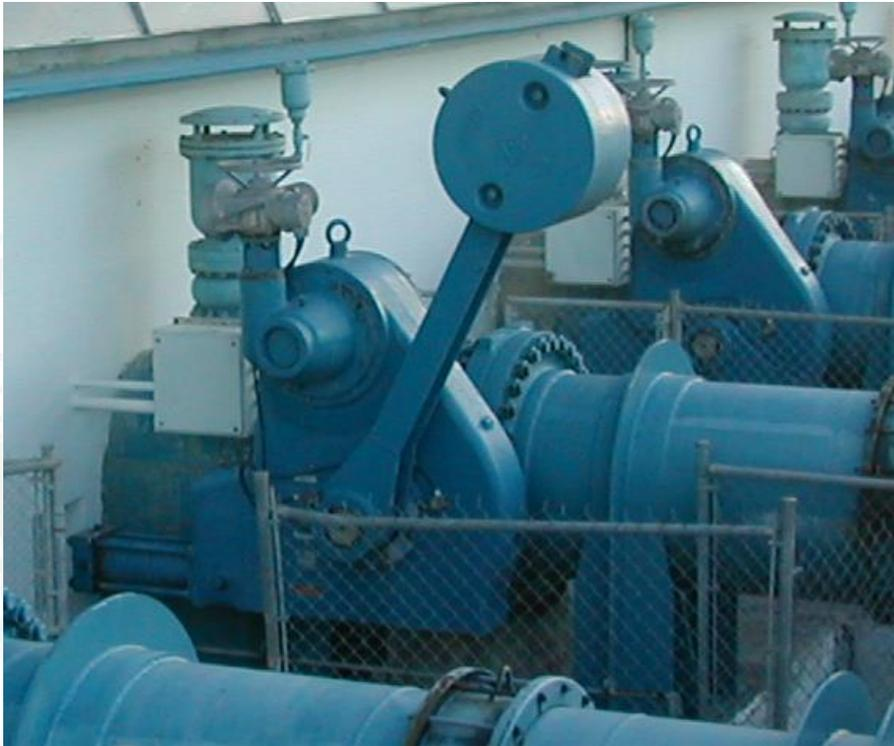
**FIGURA 5.20** VÁLVULA DE RETENCIÓN CON AMORTIGUAMIENTO
