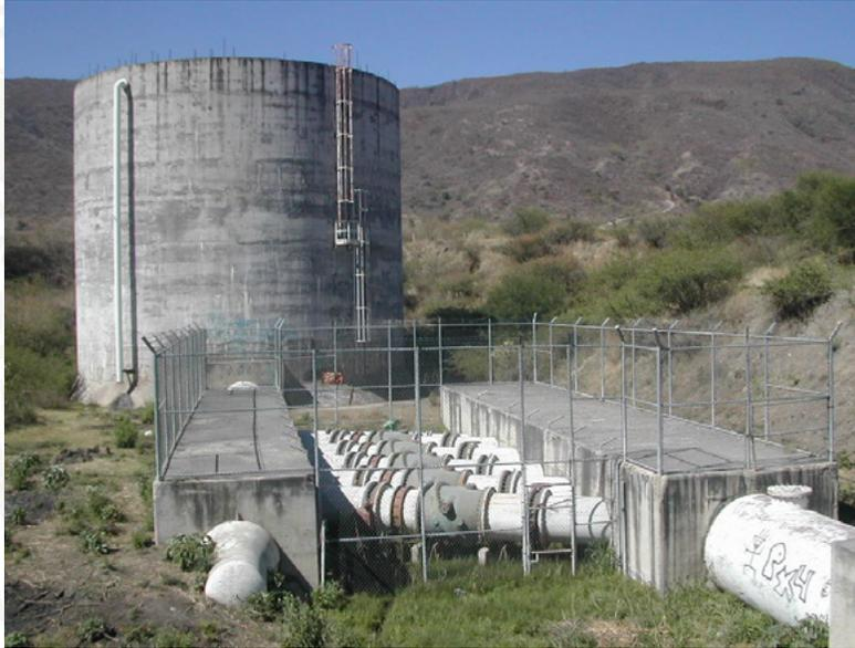
**FIGURA 5.34** TANQUE UNIDIRECCIONAL DE 18 M DE DIÁMETRO Y 18 M DE ALTURA
