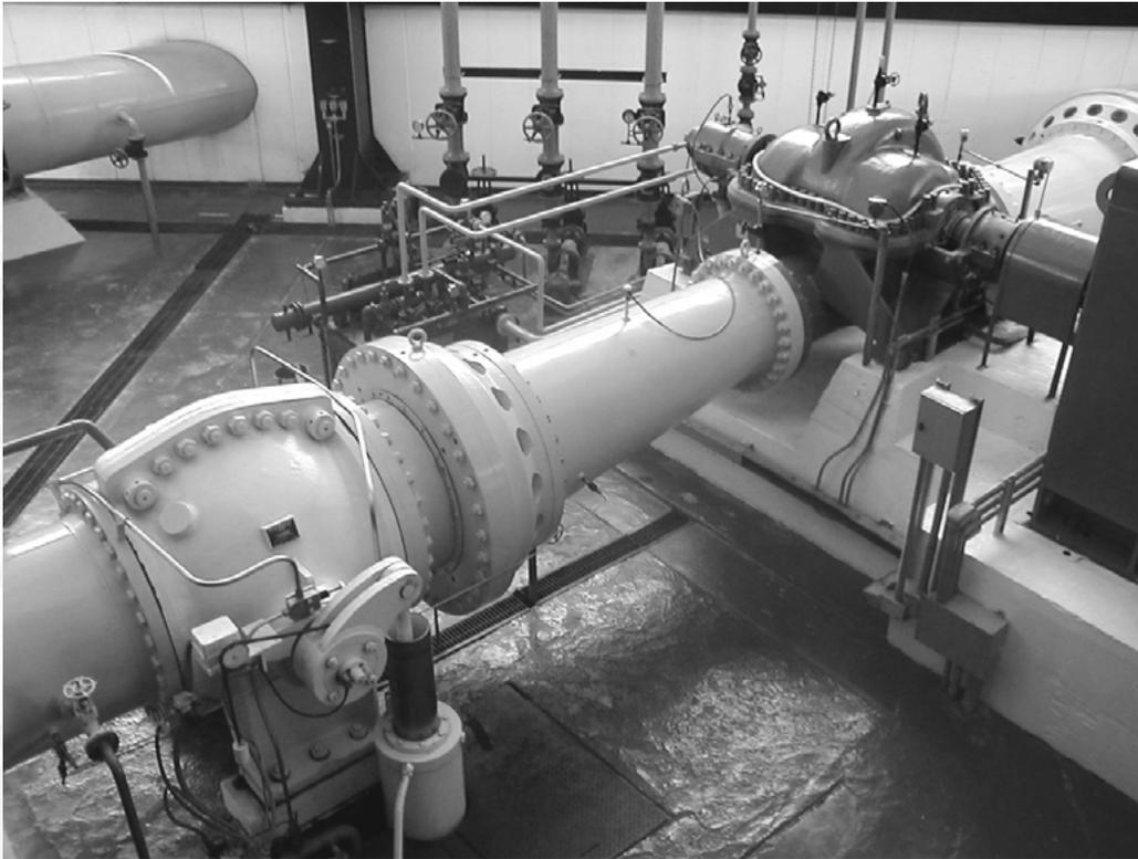
**FIGURA 4.34** VÁLVULA ESFÉRICA DE LA PLANTA DE BOMBEO DEL SISTEMA CUTZAMALA
