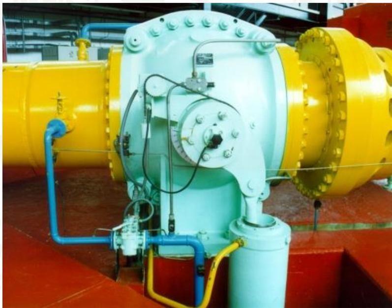
FIGURA 5.17 VÁLVULA DE CONTROL DE FLUJO EN LA DESCARGA DE UNA BOMBA
