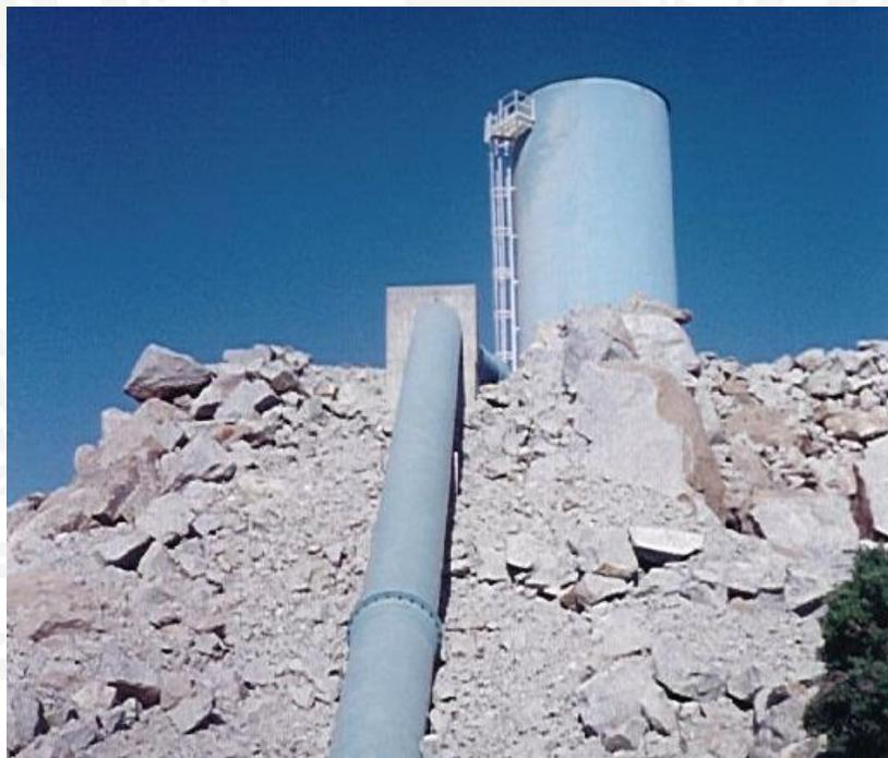
FIGURA 5.32 ASPECTO DE UNA TORRE DE OSCILACIÓN DE 7 m DE DIÁMETRO Y 40 m DE ALTURA
