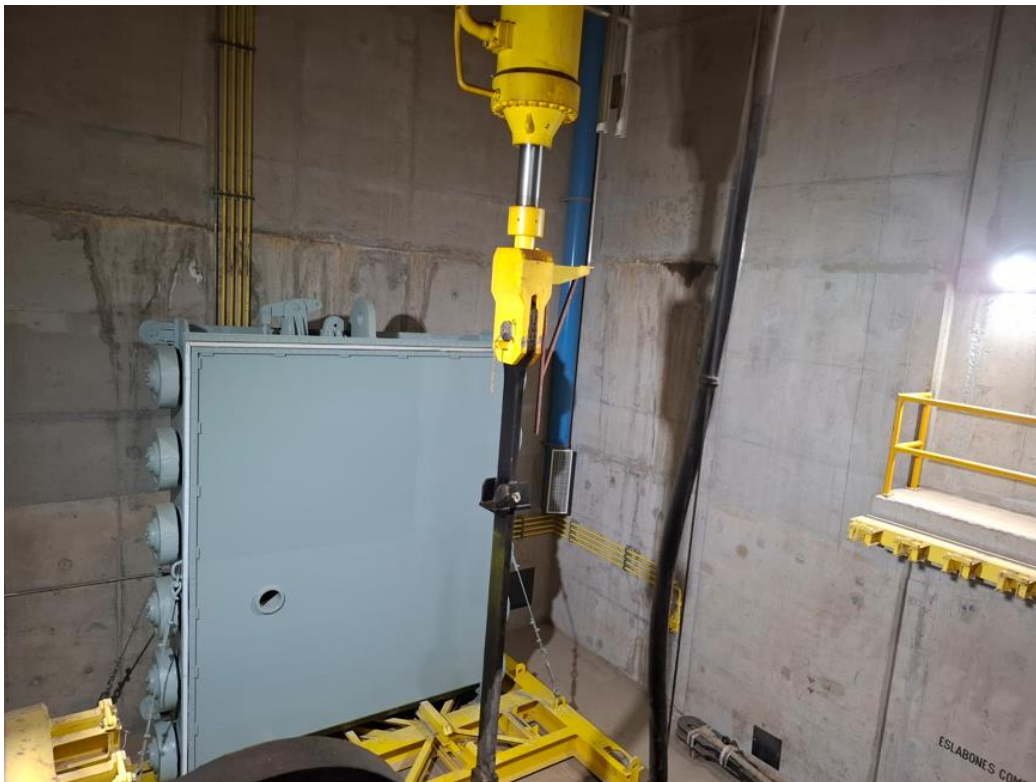
Compuerta de 3.60 metros de ancho por 4.70 metros de altura de la obra de toma.
