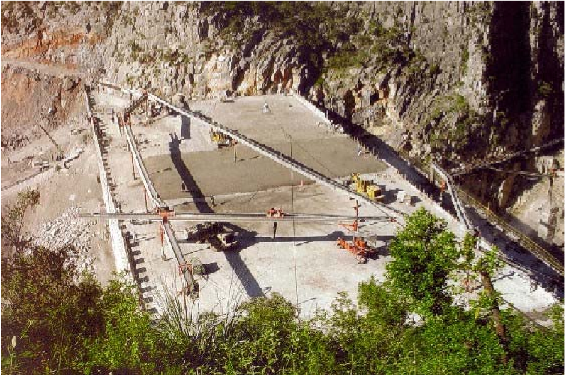
Concreto compactado con rodillo
