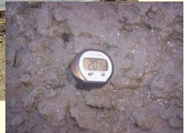
Control de la temperatura del concreto al momento del colado
