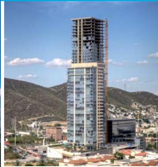
También a nivel específico lo hacen sobresalir sus conceptos implementados en la iluminación y ventilación natural para volver realidad el ahorro en consumo eléctrico y de aire acondicionado, sin demeritar el confort interno; el bajo costo de mantenimiento que se proyecta a lo largo de toda la vida útil del edificio; una planta de tratamiento de agua para reciclar el volumen empleado y mantenerlo en un proceso de reciclamiento controlado, y finalmente
