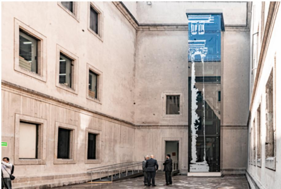
El elevador, con acceso a los tres niveles del edificio, tiene como base una estructura metálica reversible, es decir, que se puede desinstalar en cualquier momento, y recubierta con cristal templado al cual se le colocó una impresión digital en forma de una columna jónica, elemento arquitectónico característico del Palacio de Minería. Cabe señalar que el proyecto incluyó rampas de acceso en el patio y en los dos niveles que conectan con el elevador.
